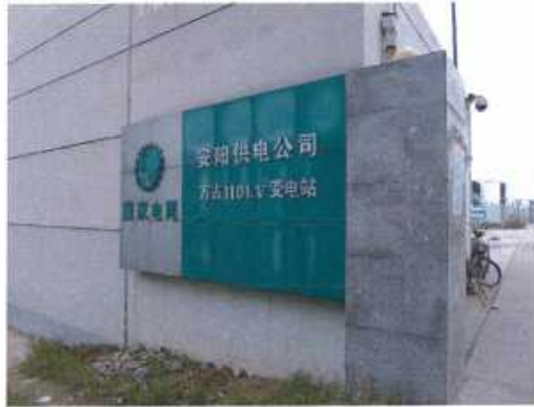
图1 万古 110kV 变电站
