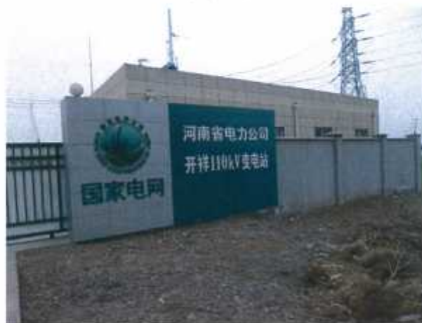
图1 开祥 110kV 变电站
