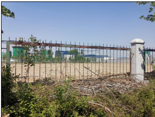
项目西侧现状
