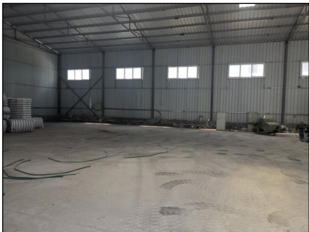
项目厂区现状图
