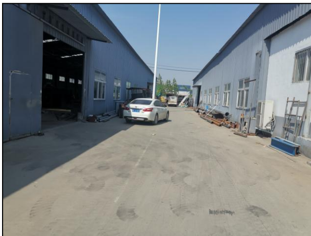
项目厂区现状图
