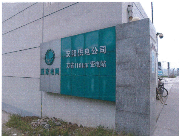
图1 万古 110kV 变电站
