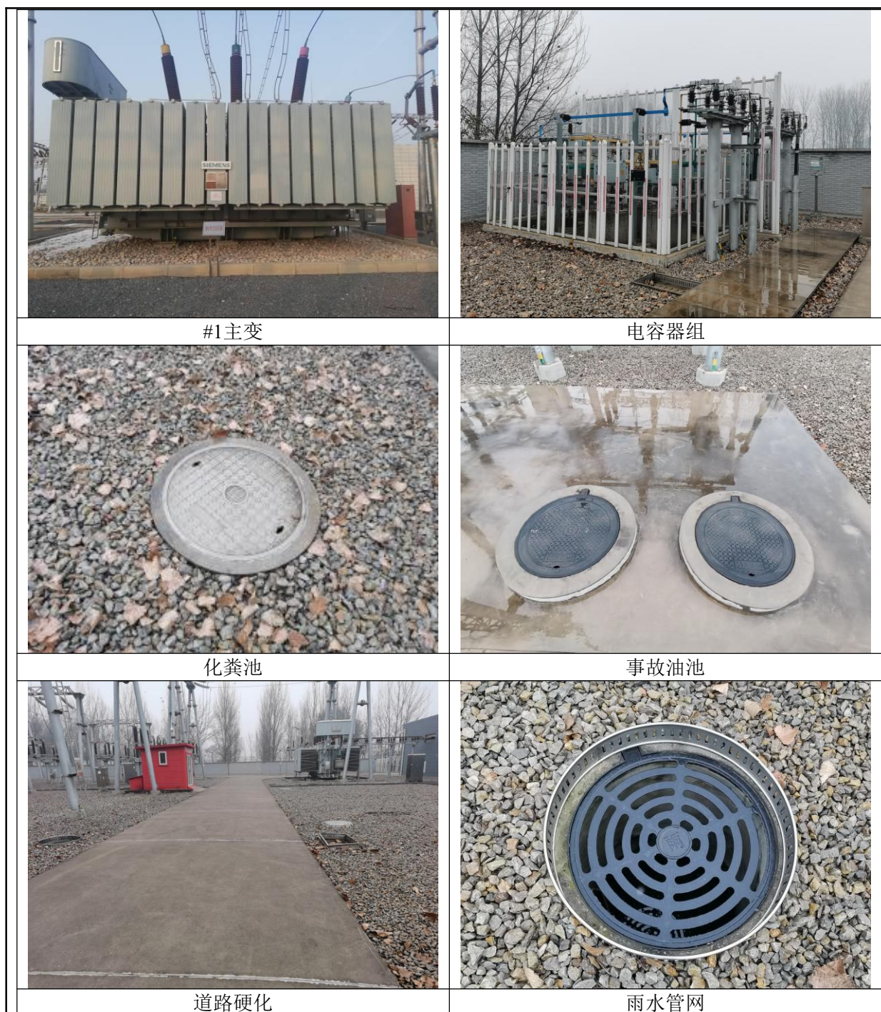
图1-3 变电站已建电气设备及相关环保设施
