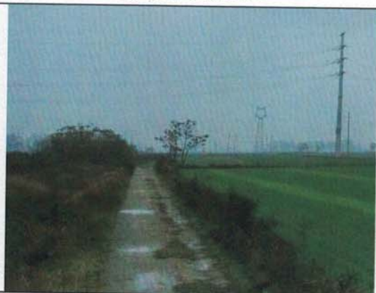
变电站东侧 110kV 配电区
