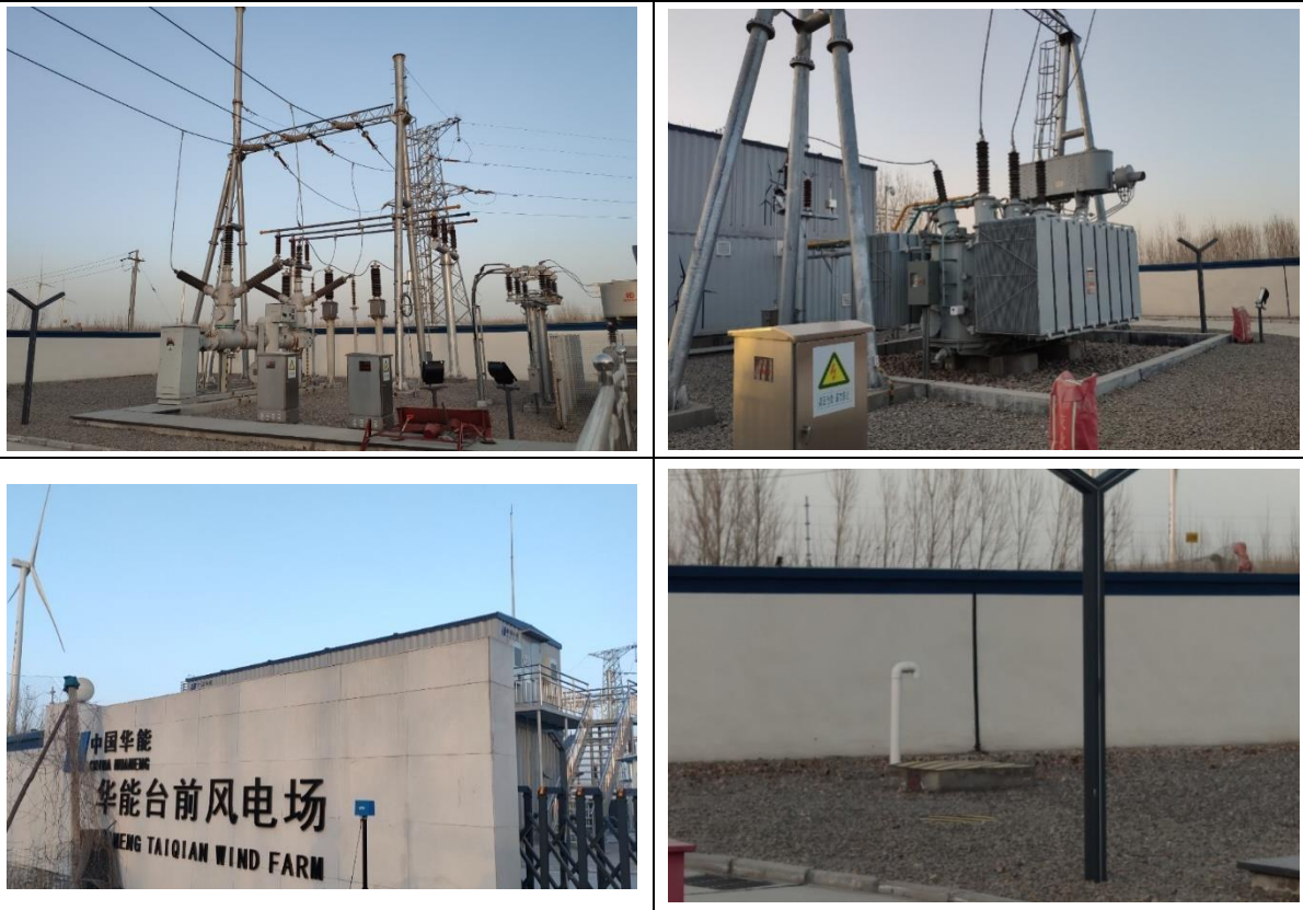
图 1-4 本工程现状照片
