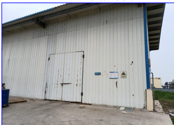
现有工程危废暂存间
