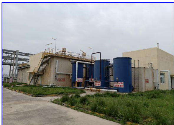
现有工程污水处理站
