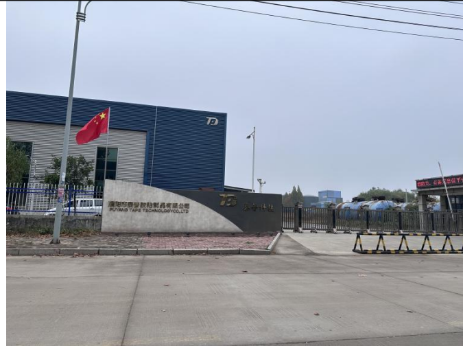
项目厂区大门
