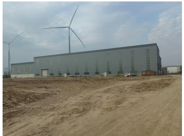
项目北侧炉渣项目
