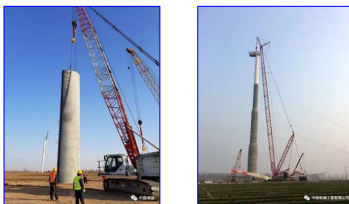
图 4 风电机组安装现场照片
