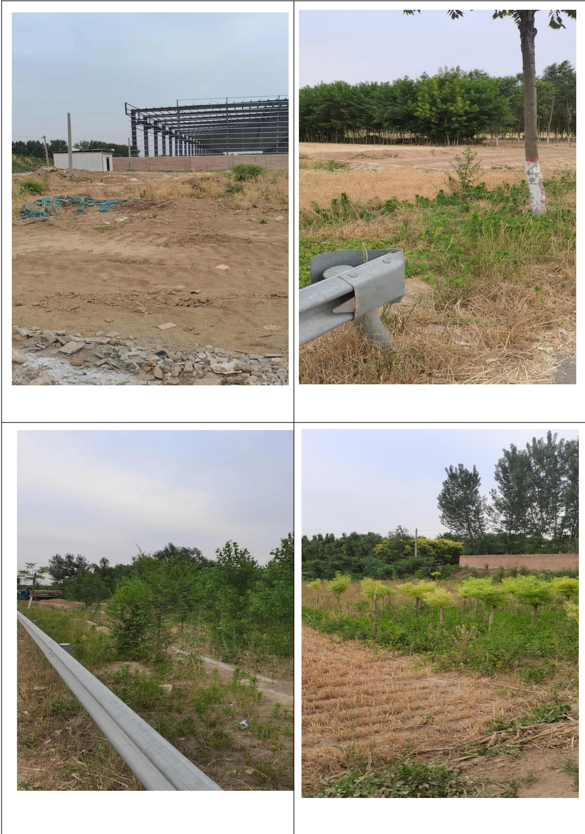
附图7 项目现场照片
