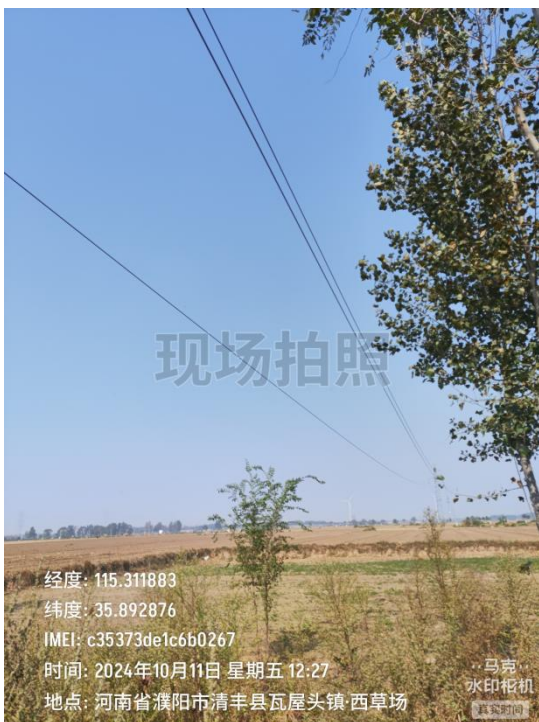
220kV 傅晓 I、II 线与本项目拟建线路 N28~N29 杆塔之间交叉处
