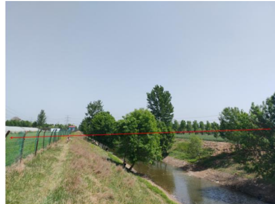
线路跨越山柳寨河
