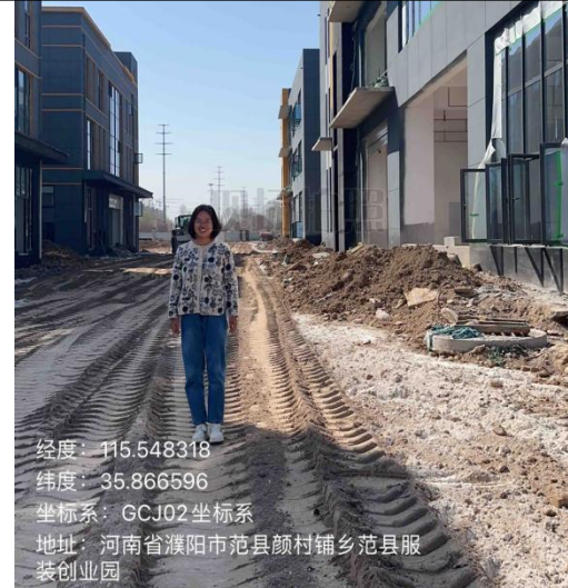
工程师现场踏勘照片
