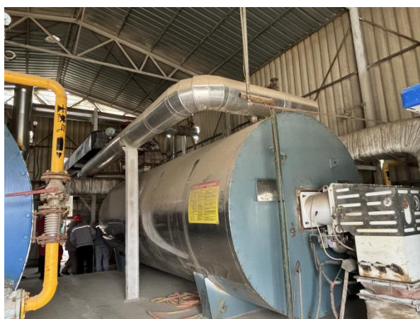
导热油炉现状
