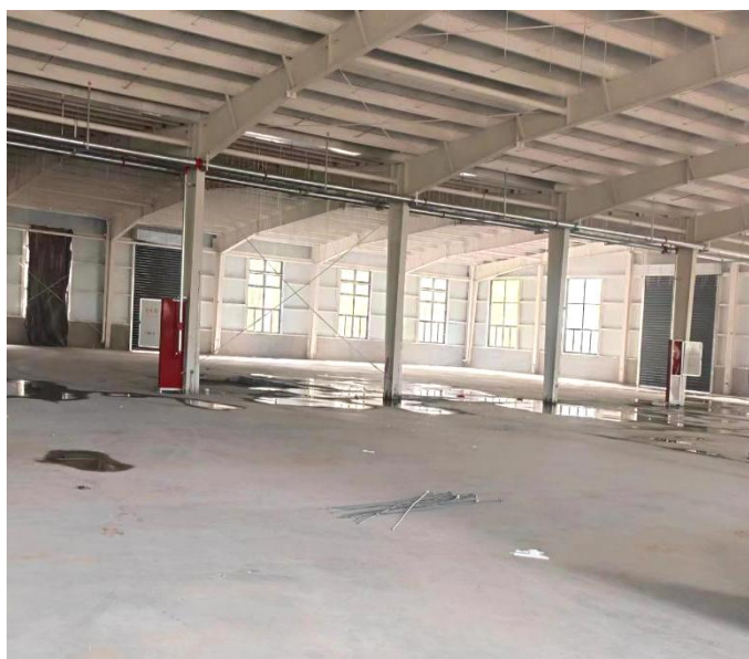
项目厂房现状
