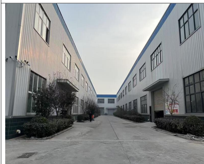
生产车间西侧
