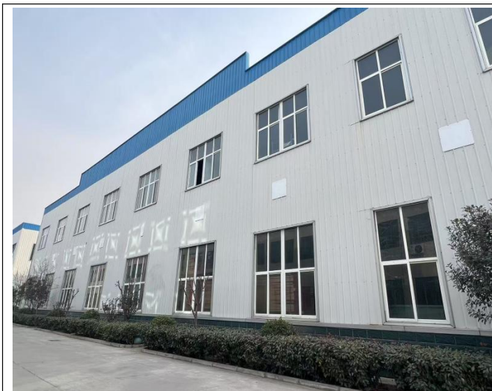
生产车间北侧
