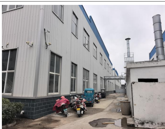
生产车间南侧
