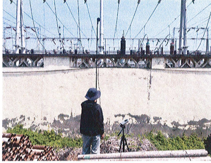
振兴 220 千伏变电站南侧厂界 1#昼间噪声检测照片
