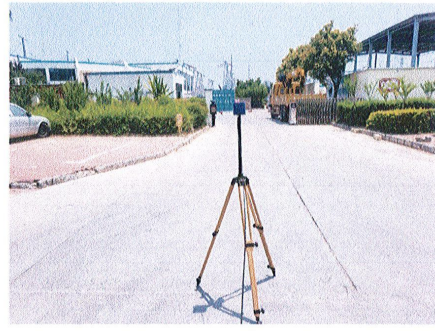
振兴 220 千伏变电站西侧断面检测照片
