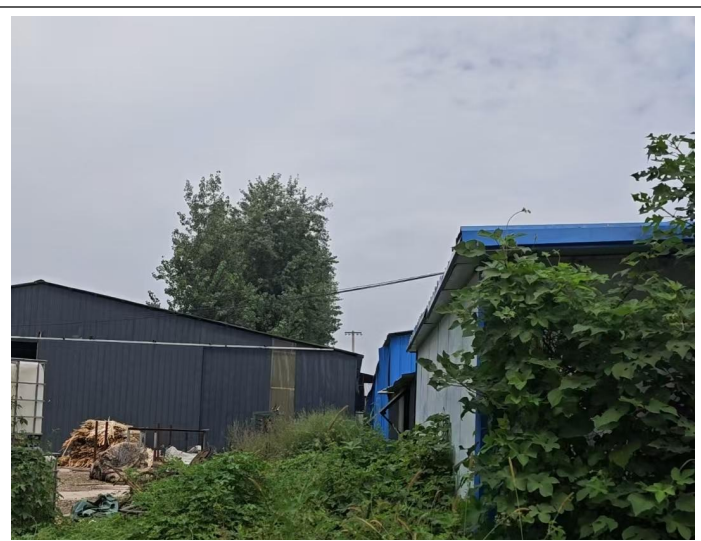
项目厂区西侧
