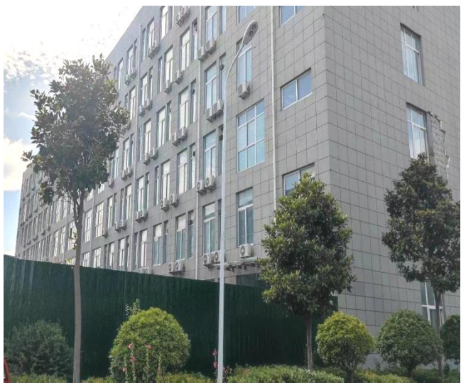
2#车间西侧空厂房
