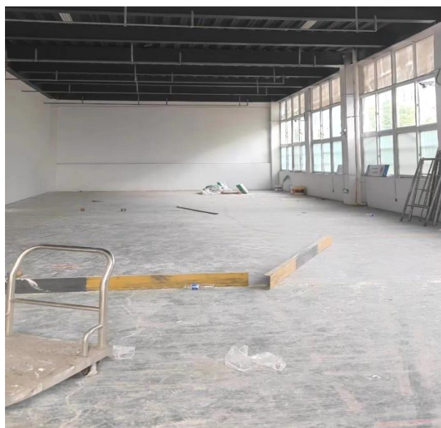
本项目 2#车间厂房
