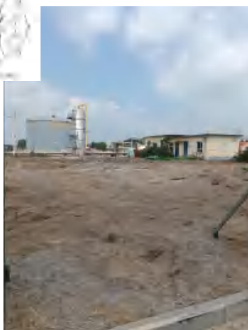
胡状联合站内余热综合利用建设区域
