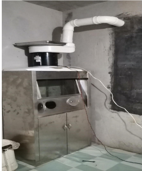
图 10-5 现有通风橱及排风管道照片
