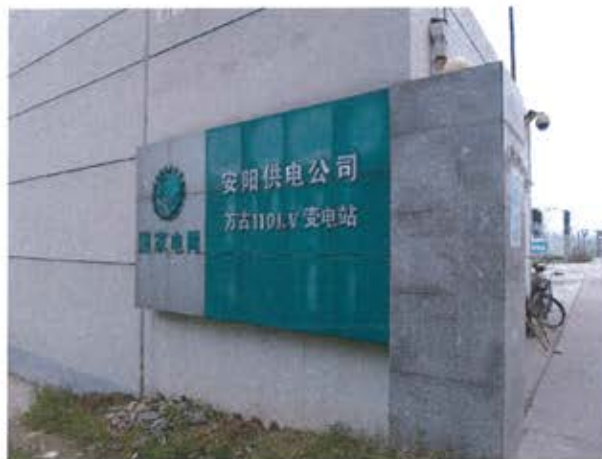
图1 万古 110kV 变电站
