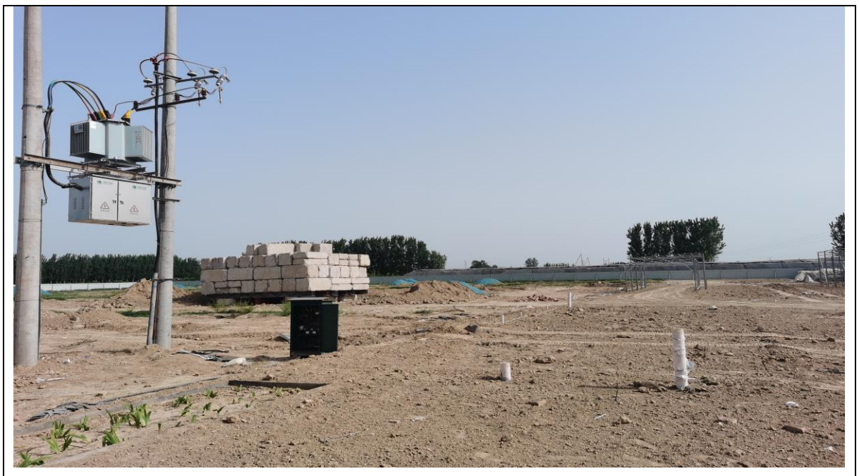
图2-4 铁丘220kV变电站站址处现状照片
