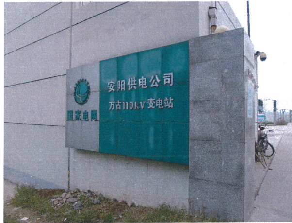
图1 万古 110kV 变电站
