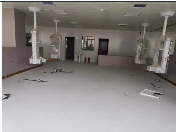
拟建机房楼上现状
