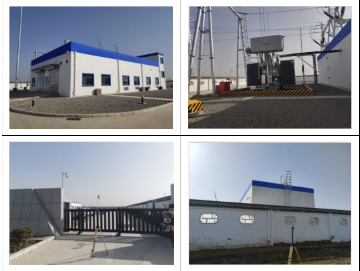
图 1-3 升压站现状照片
