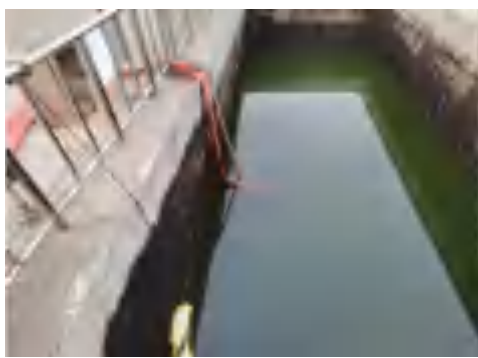
初期雨水收集池
