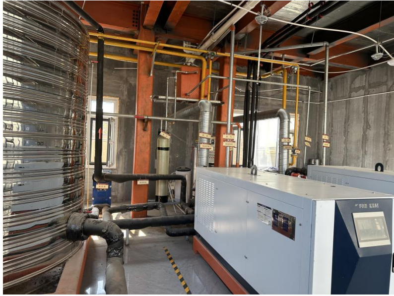
现有工程锅炉房
