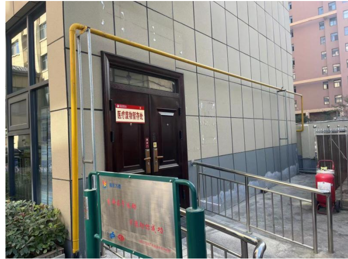
现有工程医疗废物暂存处
