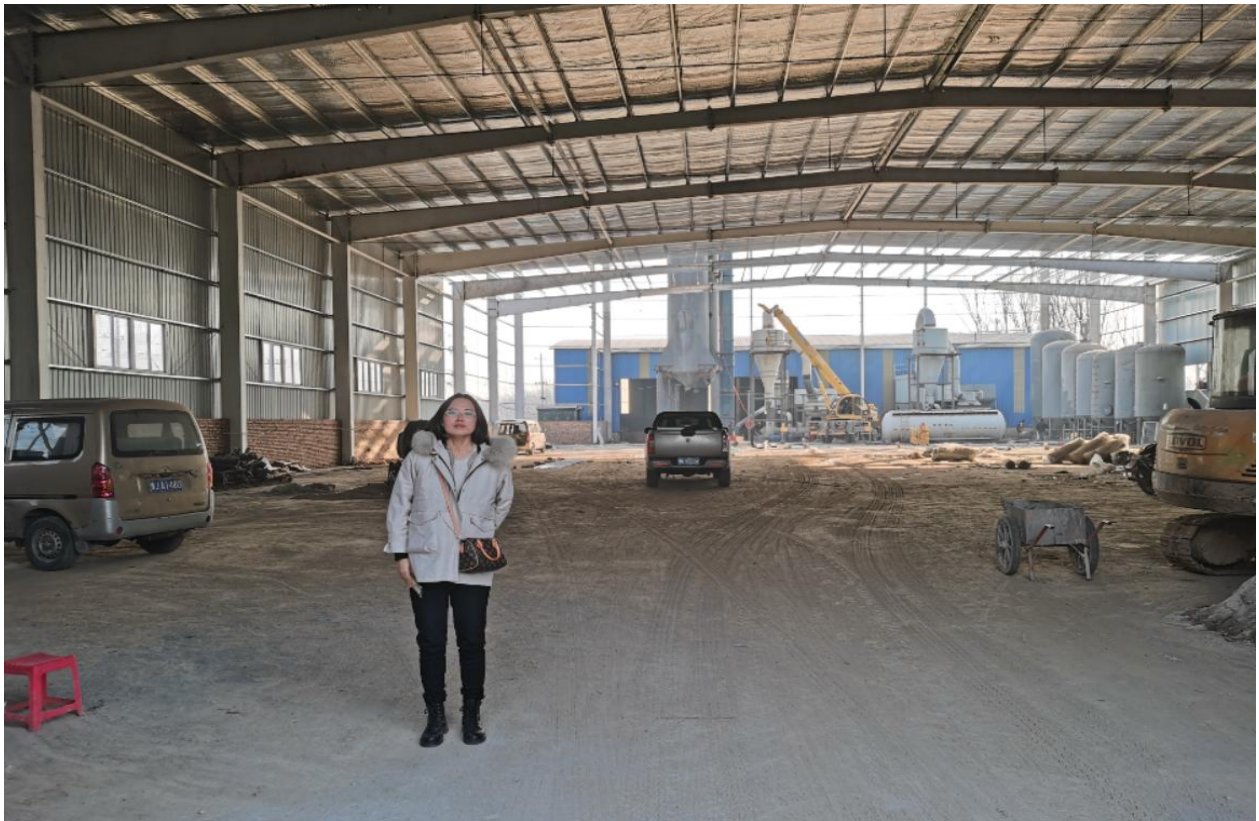
工程师现场勘察照片
