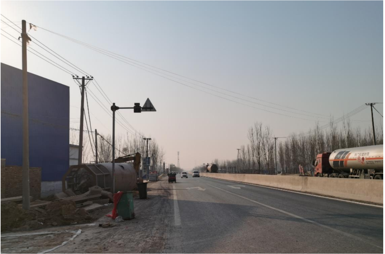
项目西侧道路
